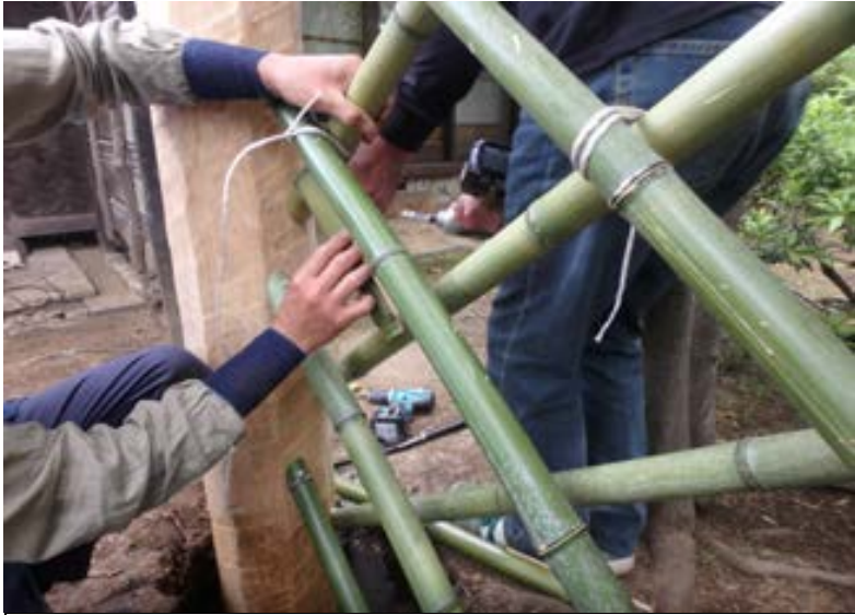
柱の両端に竹を固定作業
