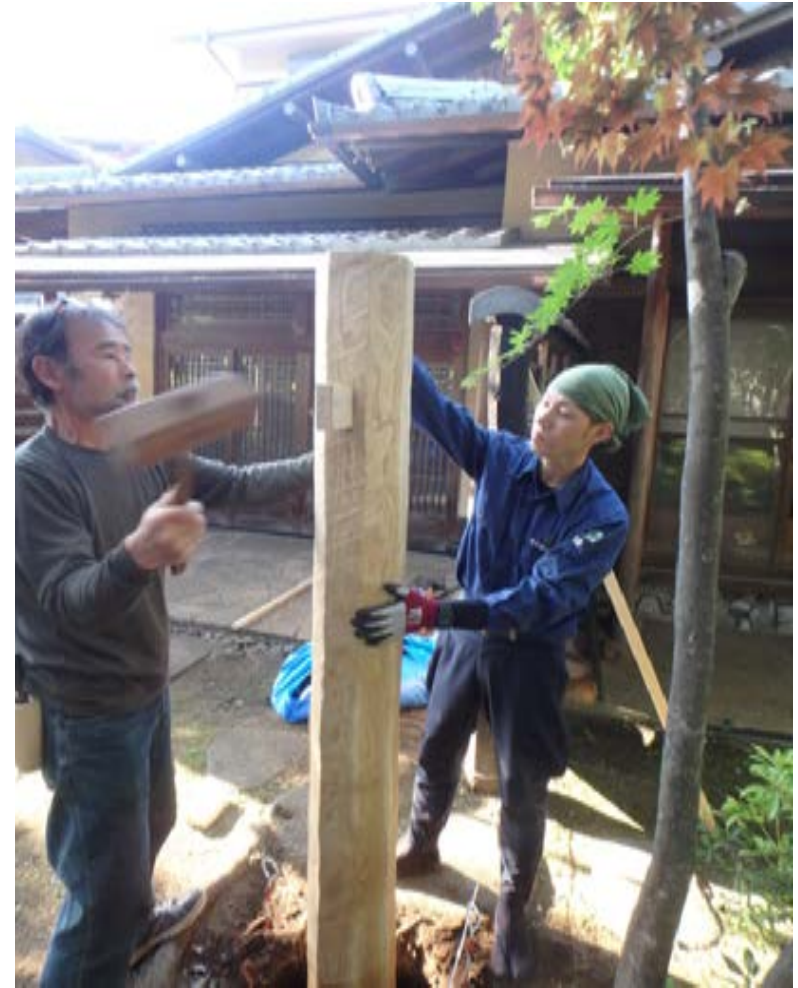
栗柱にかまちのささえのダボ打ち込み
