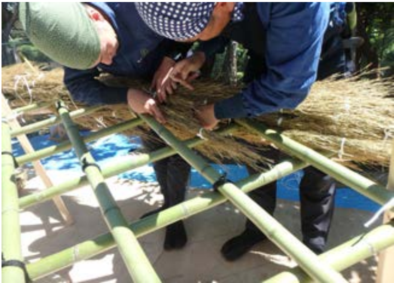
エンピ管のあいた所へ短い竹穂を束にして詰め込む
