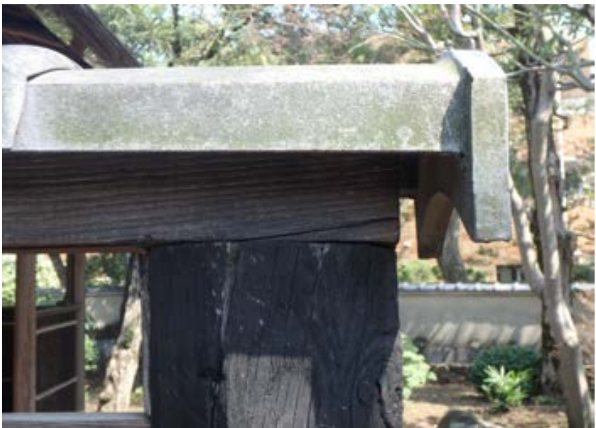
N0.5 袖垣瓦取りはずし後清掃
